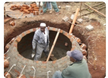
Bau von Biogasanlagen für Haushalte in Kenia
